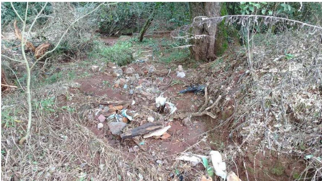
*Figura 113: Imagem da Erosão na ponta de rede da Rua da Pátria*
