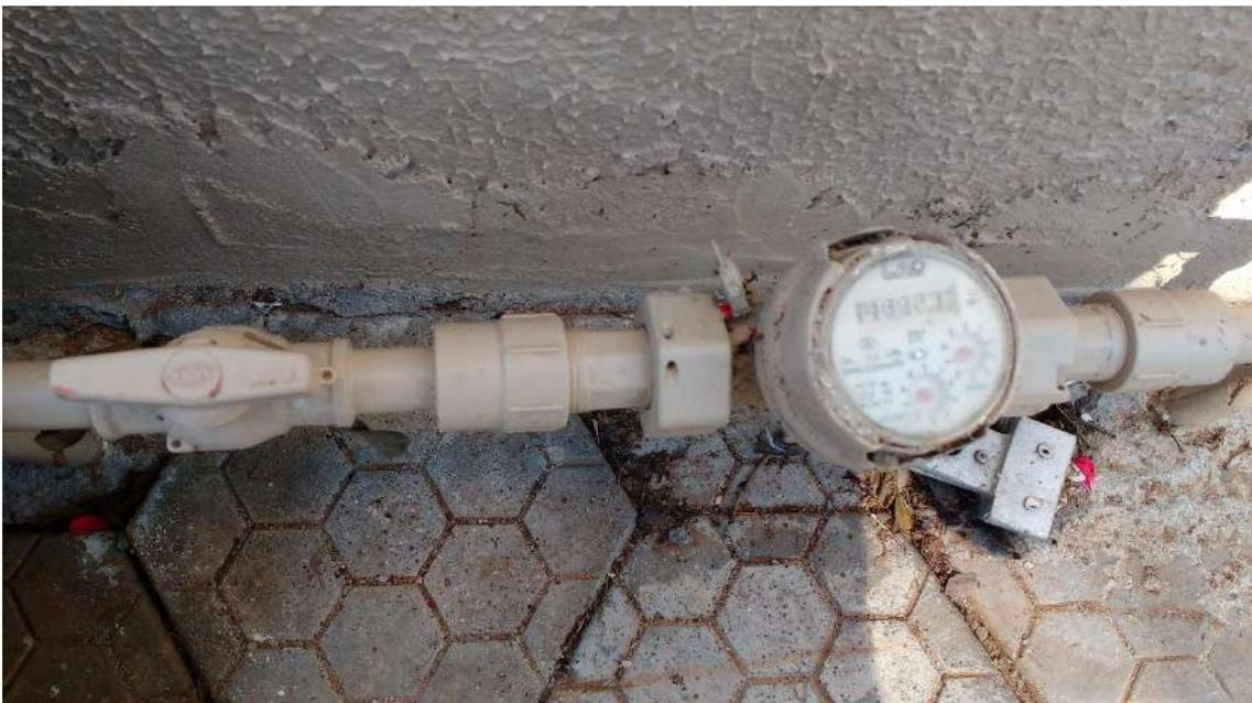
*Figura 20: Cavalete Antigo deteriorado em funcionamento*
