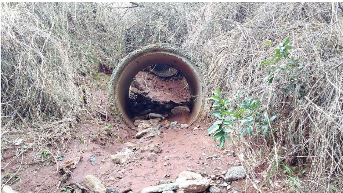
*Figura 75: Imagem da Erosão na ponta de rede antes do lançamento da Rua da Pátria*
