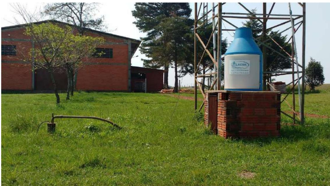
*Figura 60: Poço artesiano e tratamento da água SAC Esquina Penz*
