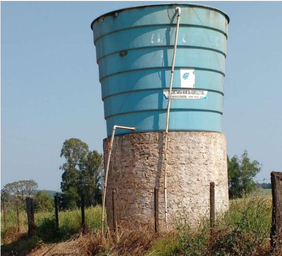
*Figura 68: Reservatório 10 m<sup>3</sup> SAC Gramado 3*
