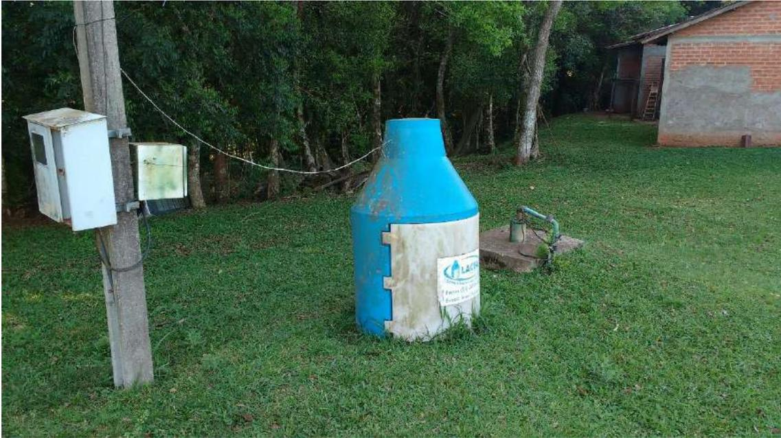
*Figura 55: Poço artesiano e tratamento da água Com. Capão do Valo*
