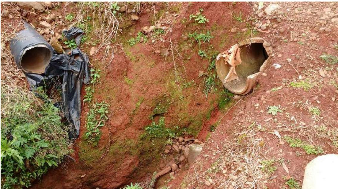
*Figura 77: Imagem da Erosão na convergência de duas redes da Rua Brasil*
