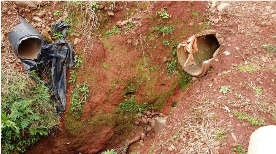
*Figura 115: Imagem da Erosão na convergência de duas redes da Rua Brasil*
