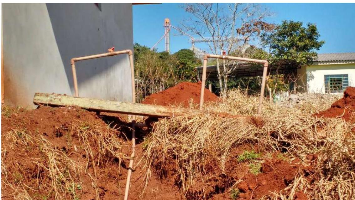
*Figura 18: Cavaletes sem hidrômetro*
