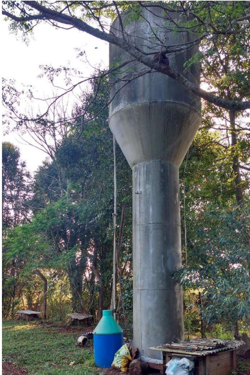
*Figura 38: Reservatório de 12m<sup>3</sup> e tratamento SAC Lutz*
