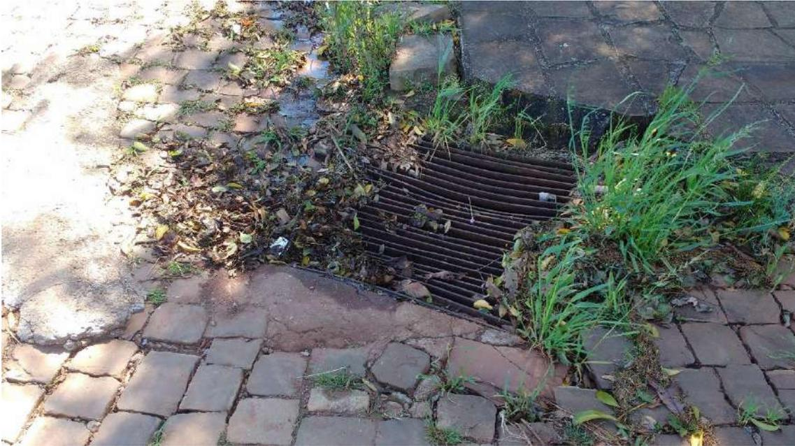
*Figura 81: Bueiro parcialmente obstruído por resíduos de varrição*
