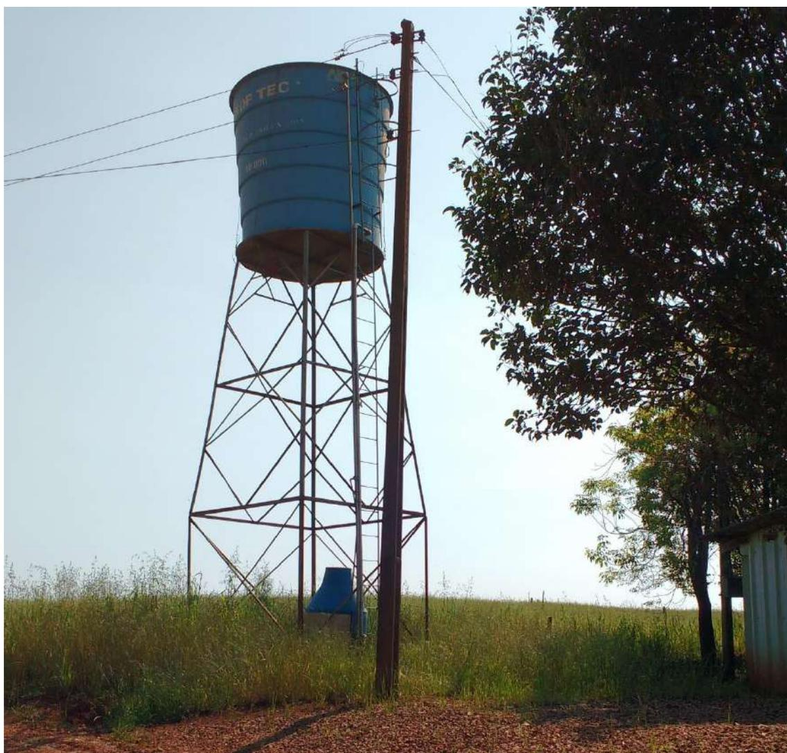
*Figura 28: Reservatório de 10m<sup>3</sup> Linha Tiese*
