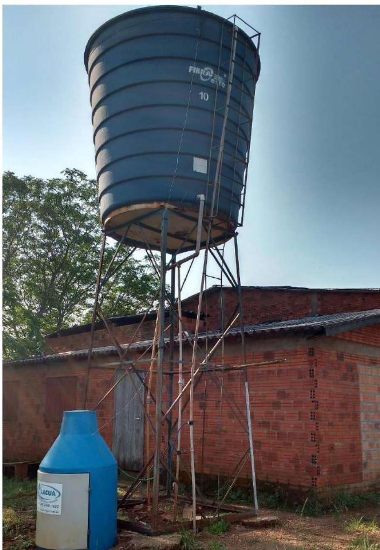
*Figura 36: Reservatório de 10 m<sup>3</sup> e tratamento da água*
