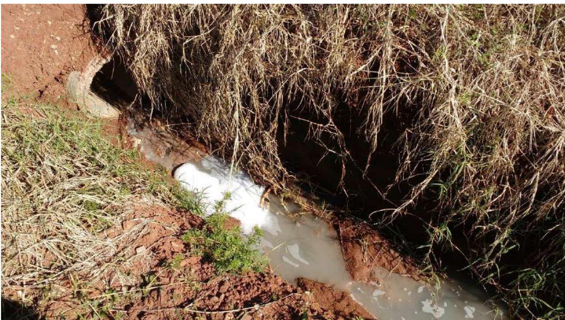
*Figura 82: Indicativo de Esgoto na drenagem Pluvial Rua Gonçalves da Silva*
