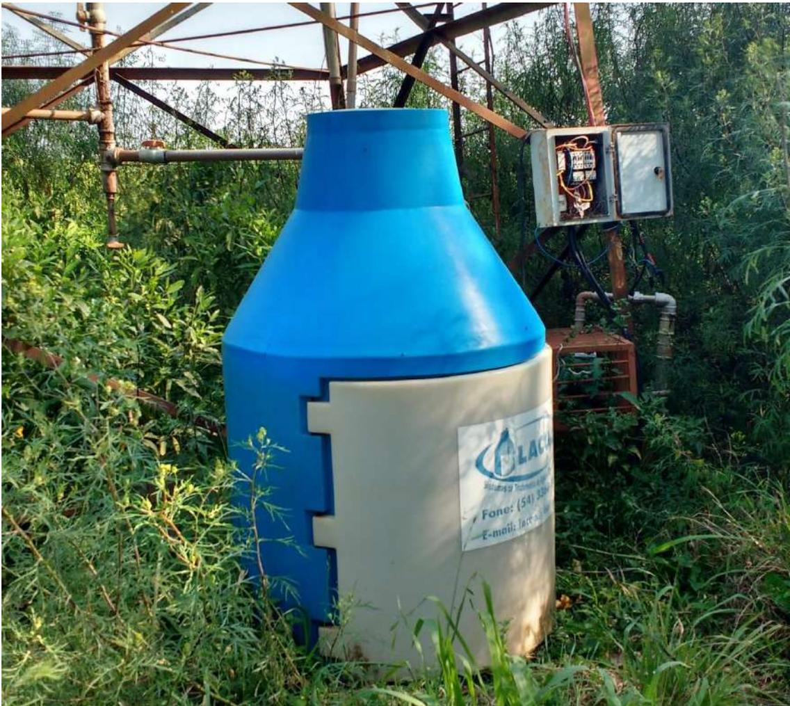
*Figura 30: Tratamento, quadro de comando e bomba de recalque*
