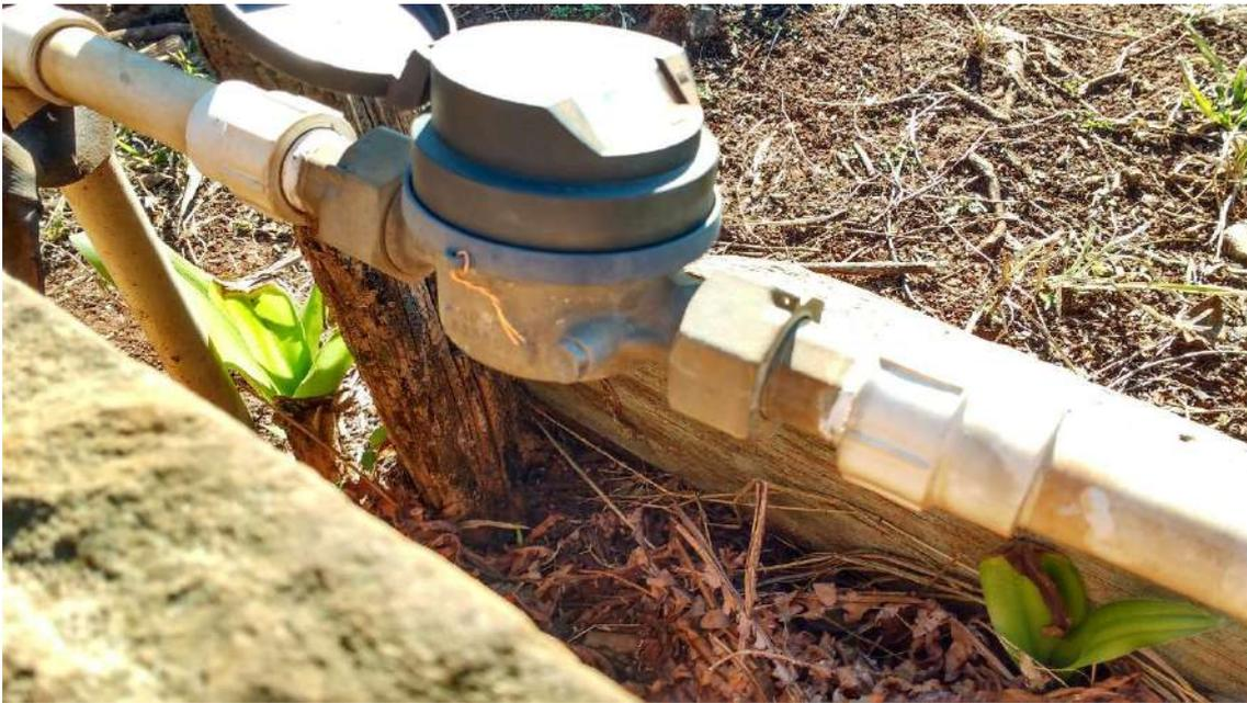
*Figura 19: Cavalete com Hidrômetro sem Lacre*
