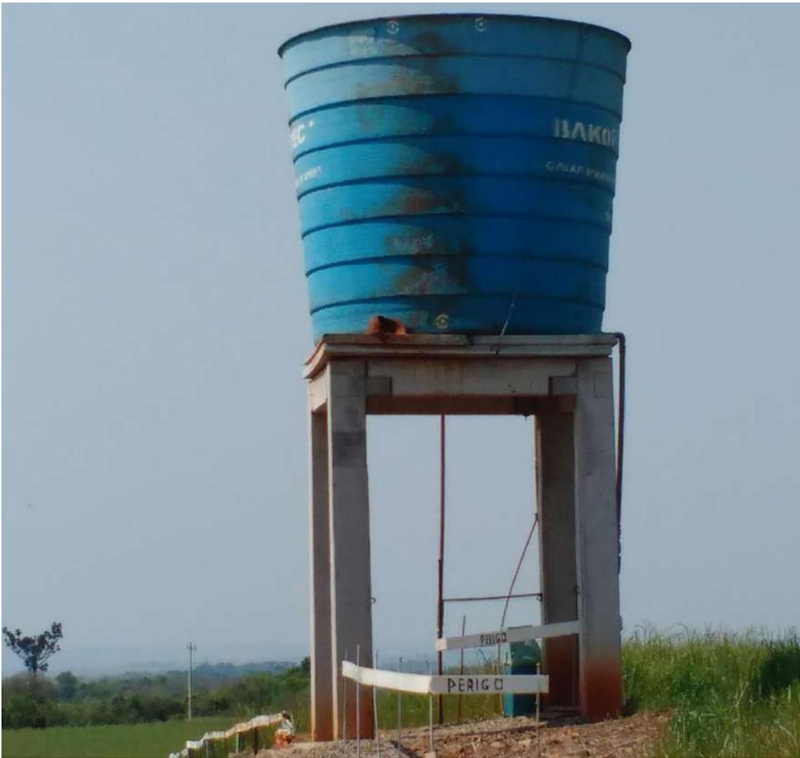
*Figura 64: Reservatório 10 m<sup>3</sup> da SAC Linha Gramado*
